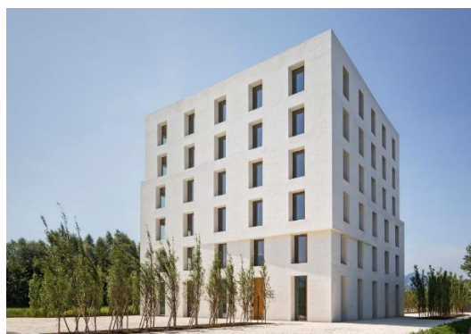
Étude de cas 2 : Immeuble BE2226 de Baumschlager & Eberle, à Lustenau en Autriche
