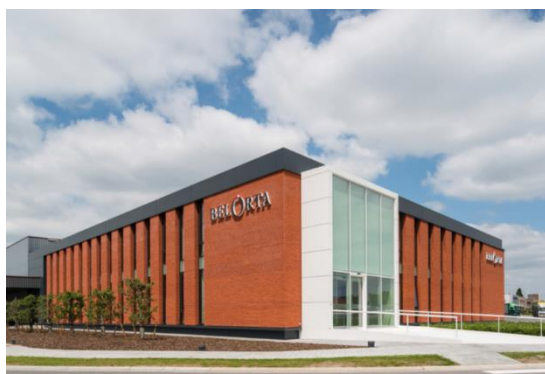
Étude de cas 1 : Immeuble BelOrta d'ar-te en Belgique
