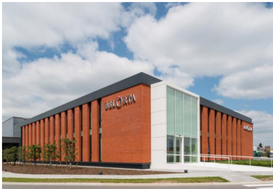
Fallstudie 1: BelOrta Gebäude von ar-te in Belgien
