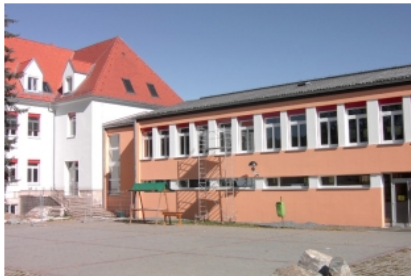
Das Schulzentrum nach der Sanierung
