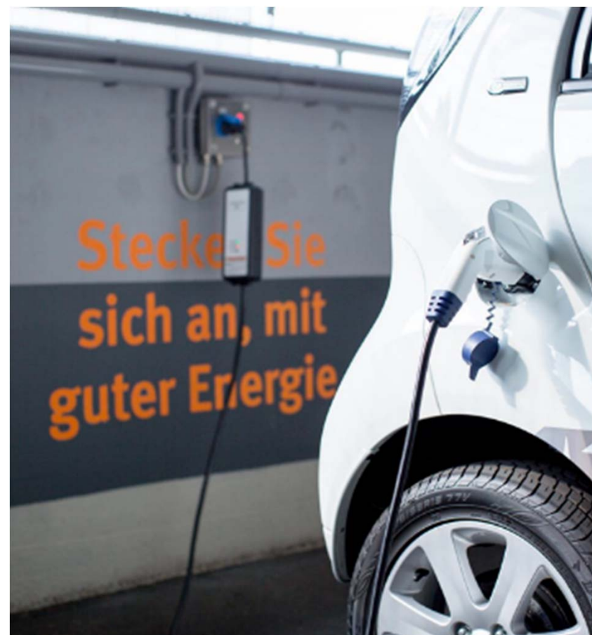
Foto: Wien Energie
