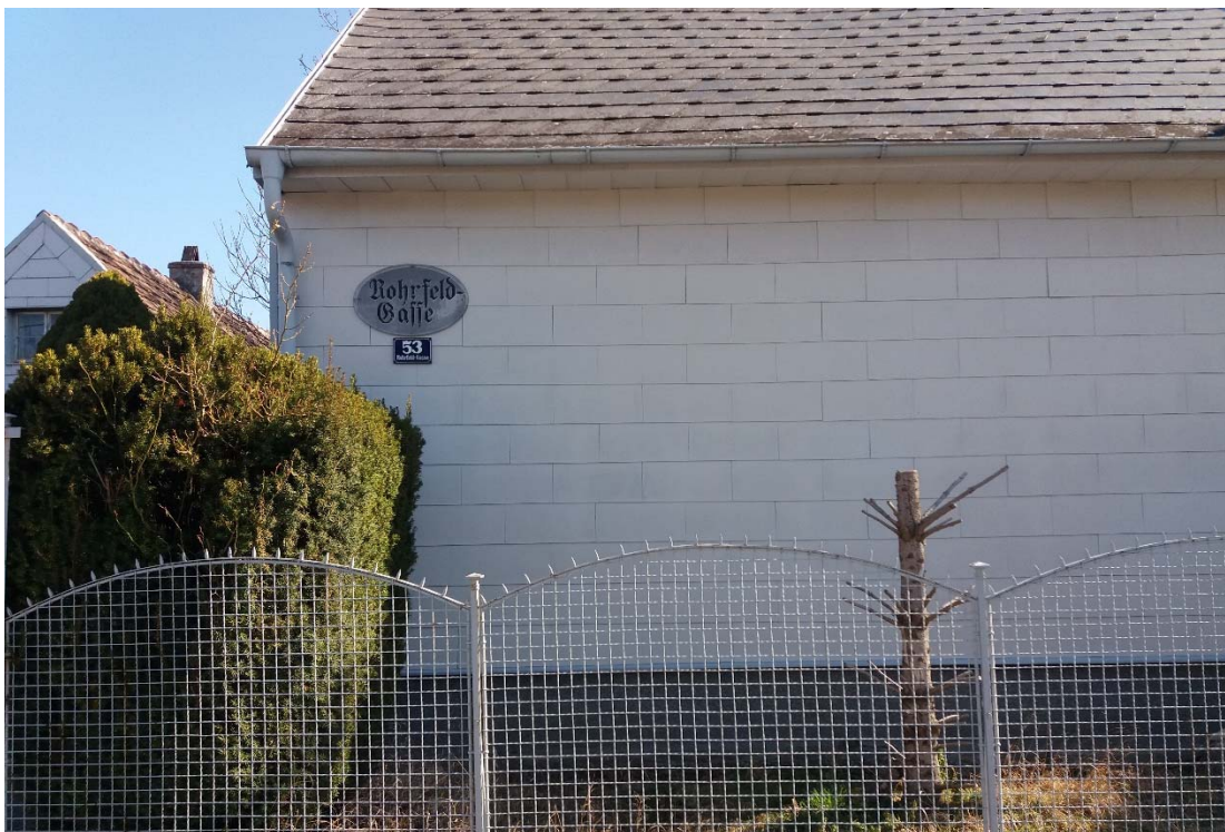
Abbildung 15: Besichtigung des Schützenviertels in Baden durch Vertreter:innen der Gemeinde Baden und der ÖGUT.
