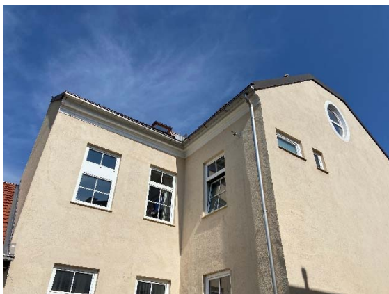
Abbildung 19: Gebäude, für das eine öffentliche Vor-Ort-Sanierungsberatung durchgeführt wurde
