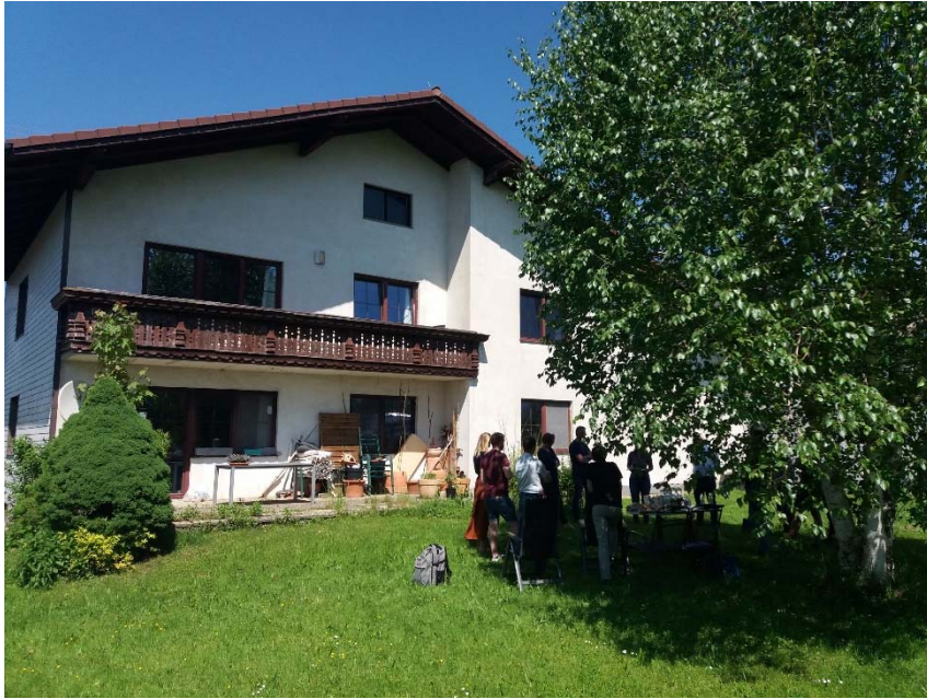
Abbildung 26: zu sanierendes Gebäude in Kirchham. Die Gruppe der Teilnehmer:innen versammelt sich im Schatten des Baumes im Garten.
