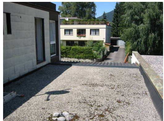
Die Terrasse vor der Sanierung
