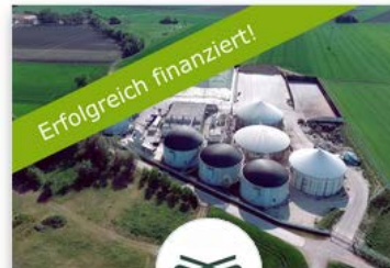
Bioenergiepark München Ost IntelligentEnergy AG & Co. KG
