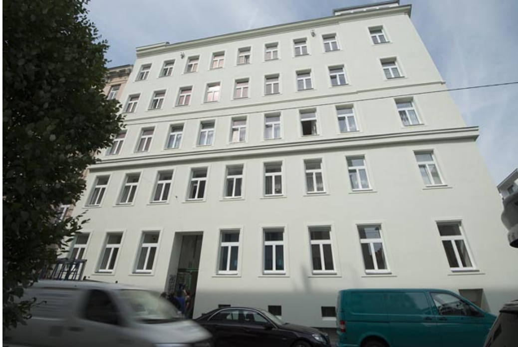
Abb. Saniertes Haus Moritzgasse 5, Quelle: www.wien.gv.at/stadtentwicklung/energie/wissen
