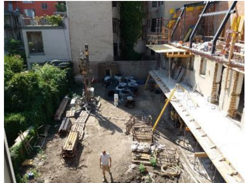
Abb.: Baustelle SMART Block Geblergasse, Bild: ÖGUT
