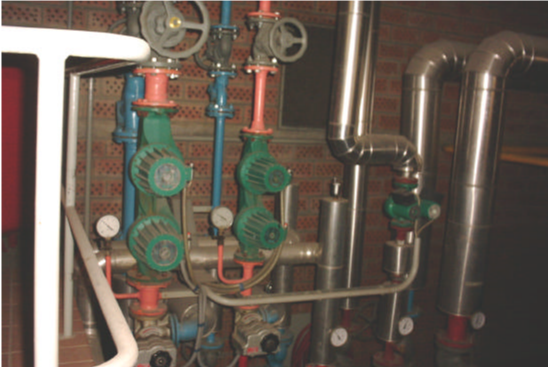
Heizanlage, Verteiler
