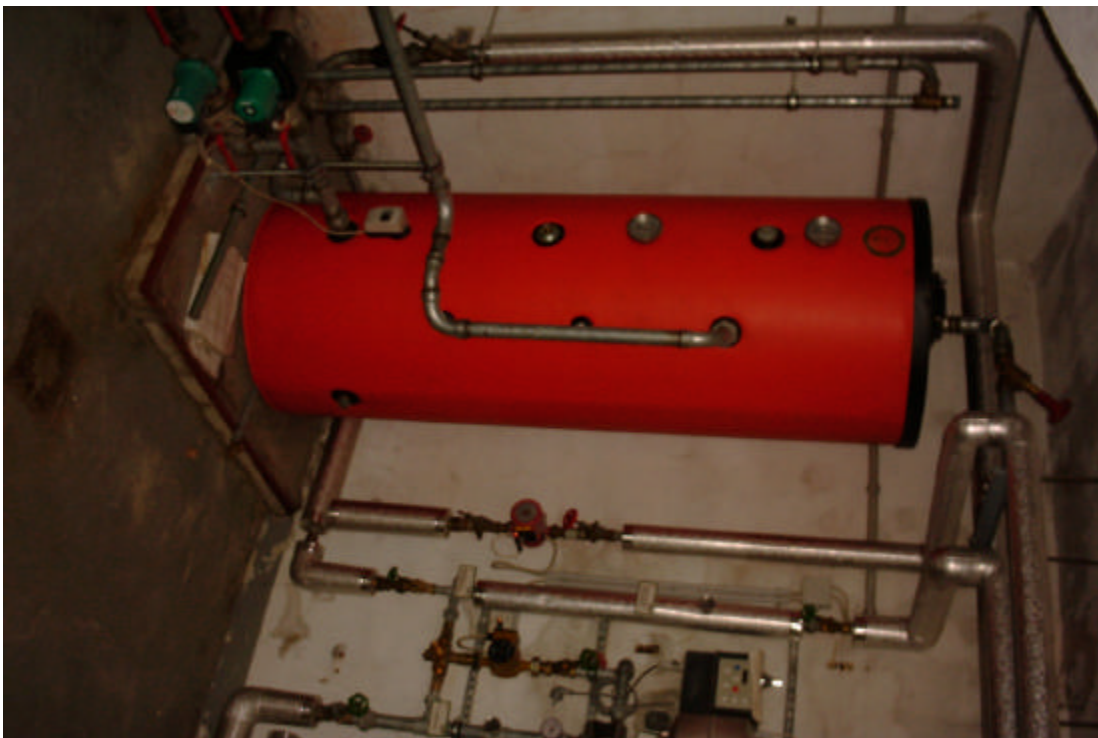
Heizanlage, Warmwasserbereitung
