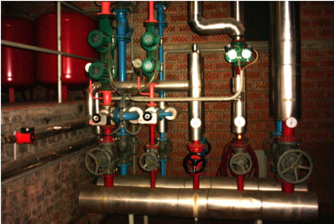
Heizanlage, Verteiler
