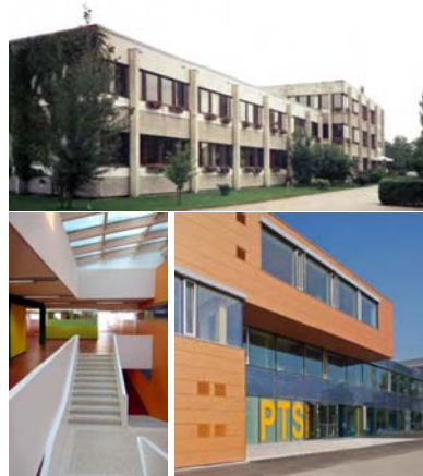
Schule Schwanenstadt, PAUAT Architekten
